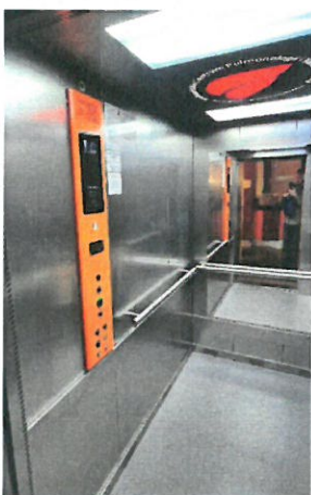
Zdjęcie nr 2: dźwig osobowy_1_2
